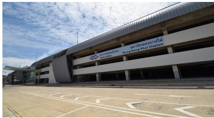
สถานีคลองบางไผ่
